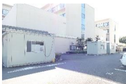
検査用コンテナ
