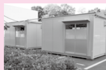
10月に増設したコンテナ2基
