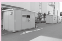
診察室は全て陰圧装置が設置されています。
